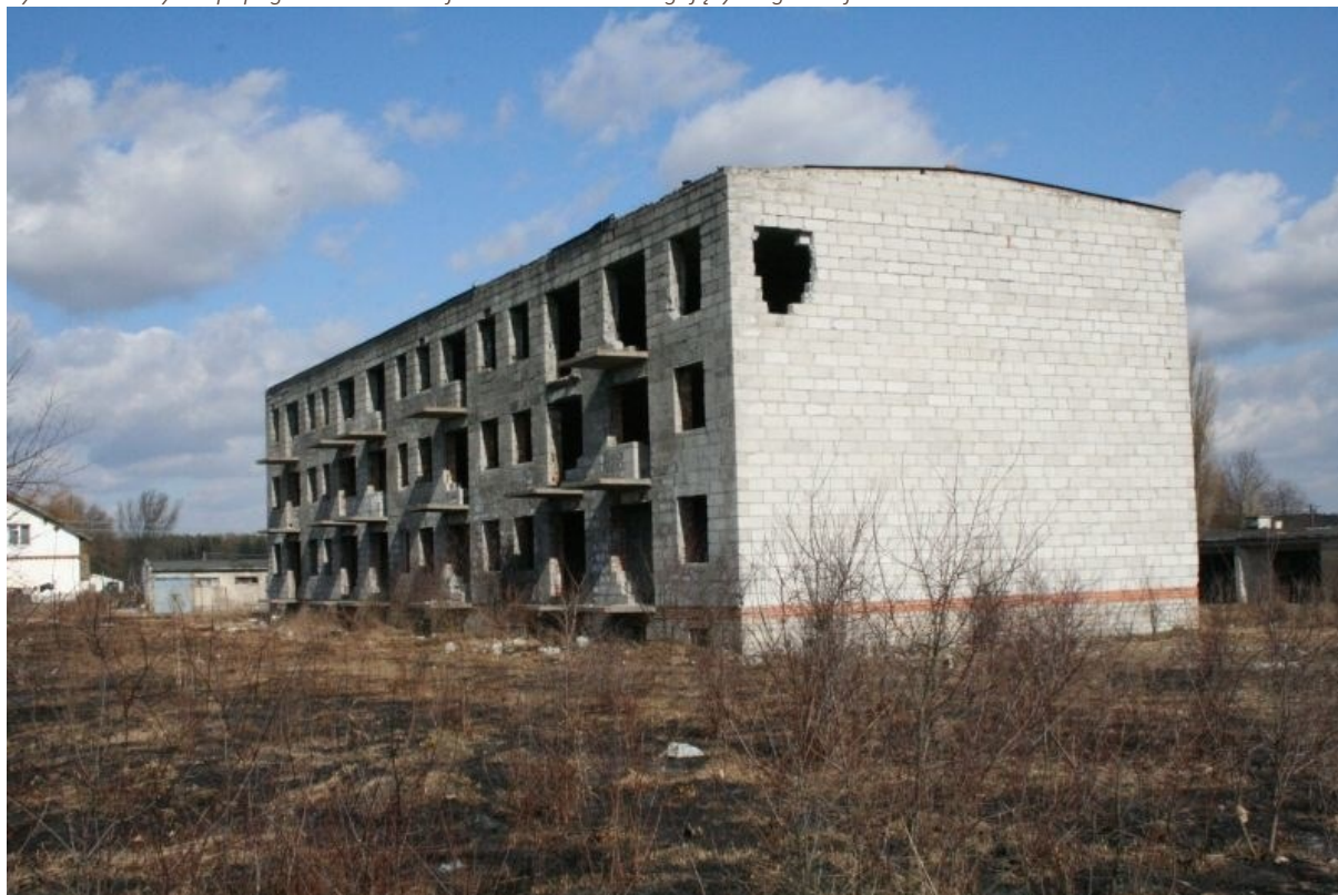
Rysunek 9 Budynek popegeerowski w miejscowości Zalesie ulegający degradacji.
